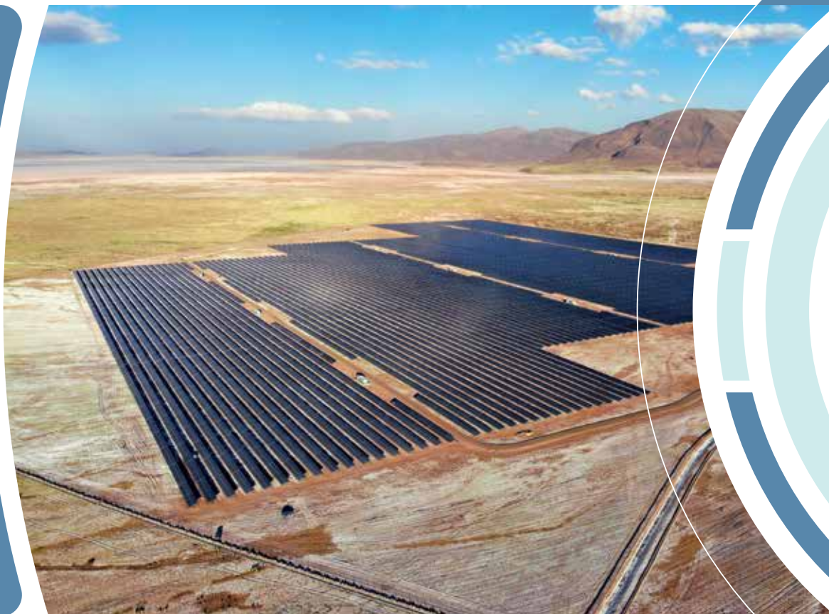
Planta Solar Fotovoltaica Oruro Fase I y II - ENDE
