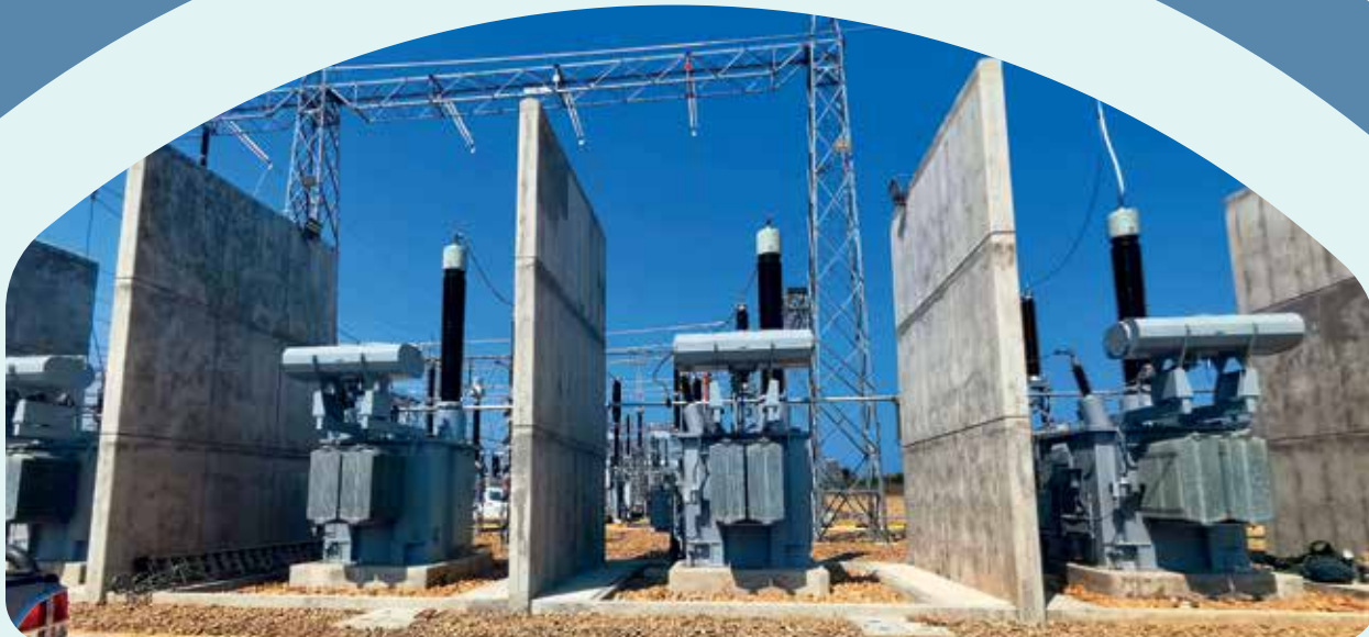
Banco de Autotransformadores Subestación Bélgica 230/115 kV - ENDE TRANSMISIÓN
