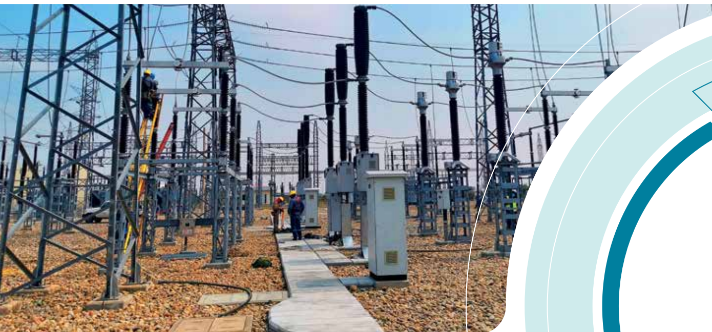
Adecuación Barras Subestación Warnes 230 kV - ENDE TRANSMISIÓN
