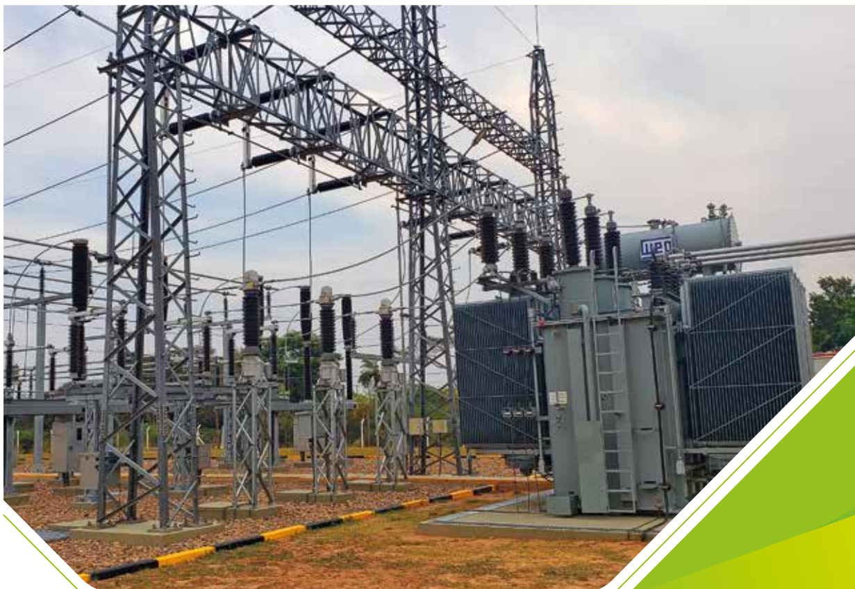
Transformador de Potencia 21AT1 Subestación Plan Tres Mil - CRE
