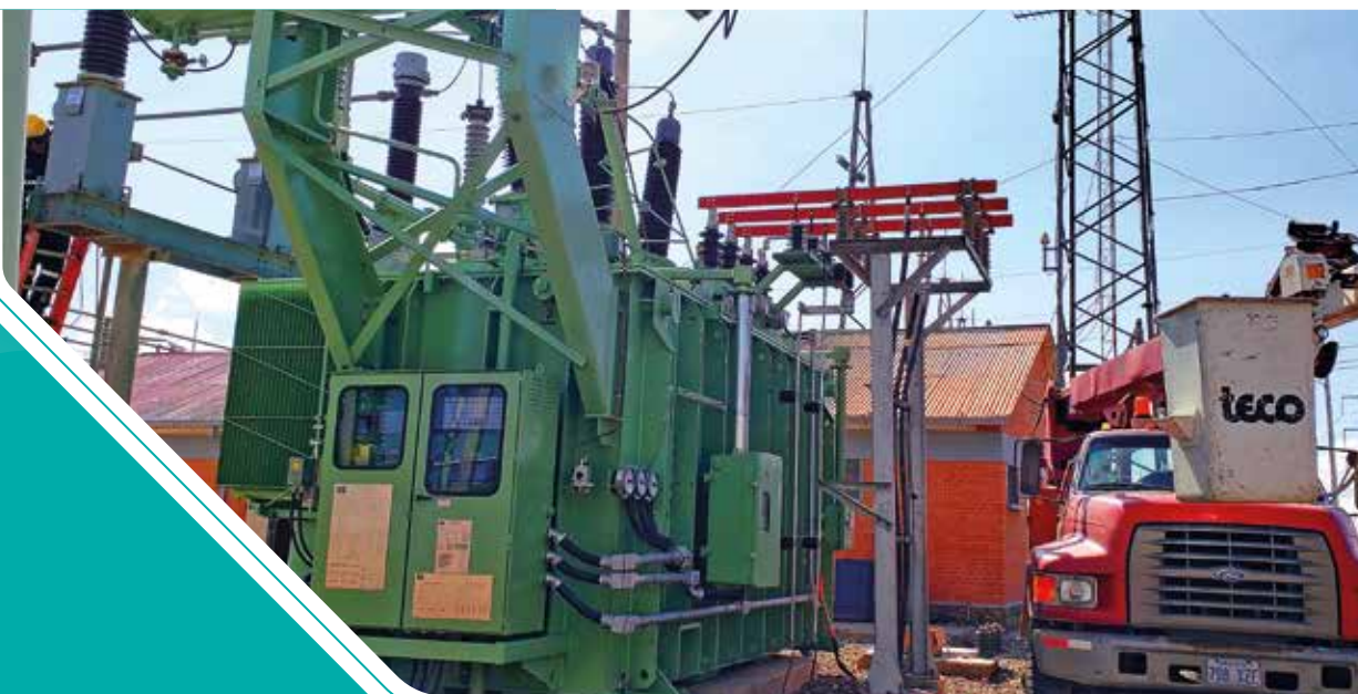
Reemplazo de Transformador de Potencia TRKEN06901 en Subestación Kenko - DELAPAZ
