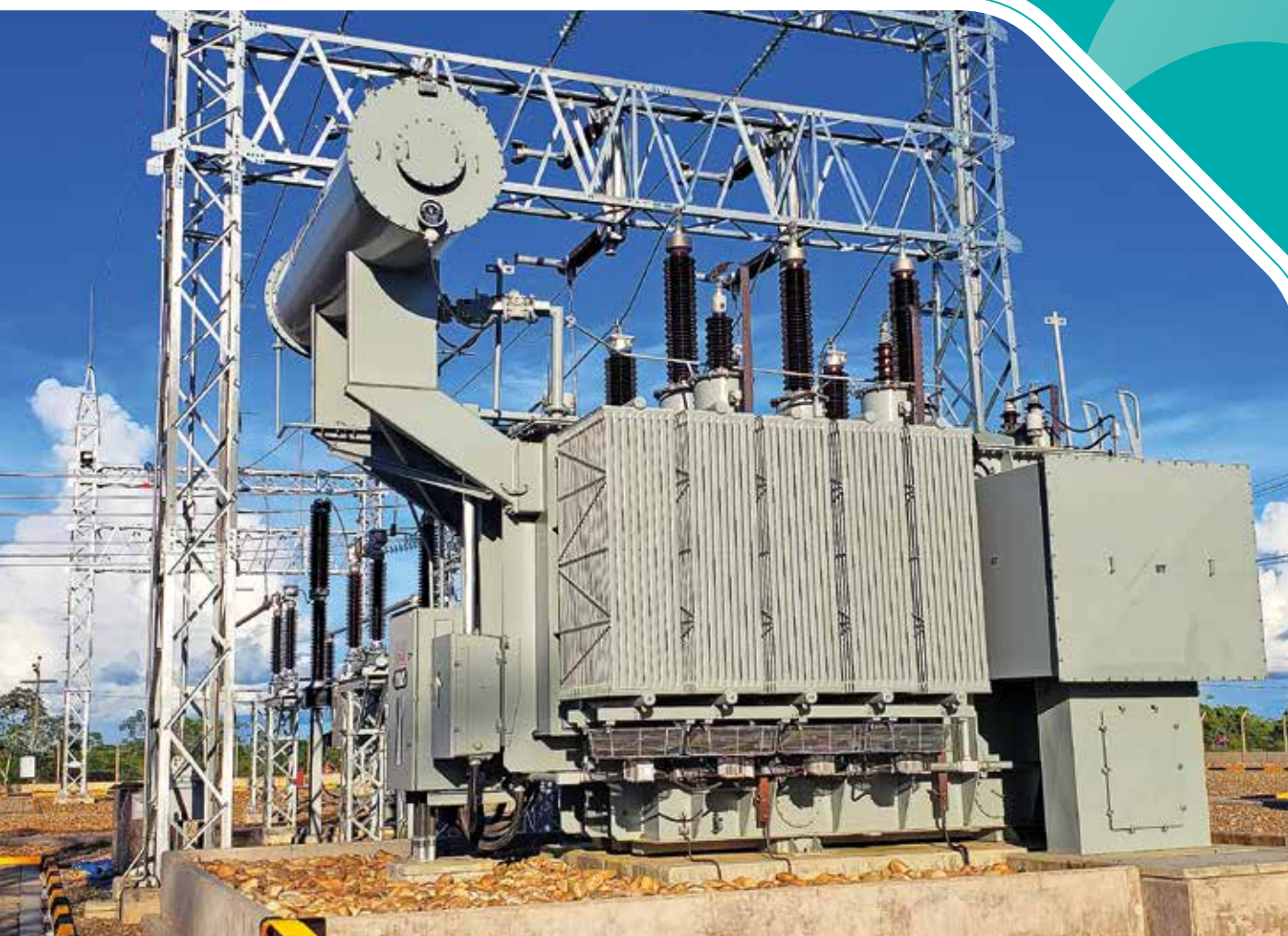
Equipo Transformador 50 MVA y Bahía de Transformación Trinidad - ENDE
