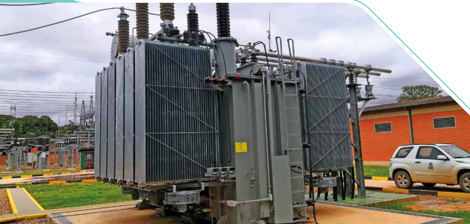
Transformador de Potencia 50 MVA Subestación Feria Exposición - CRE
