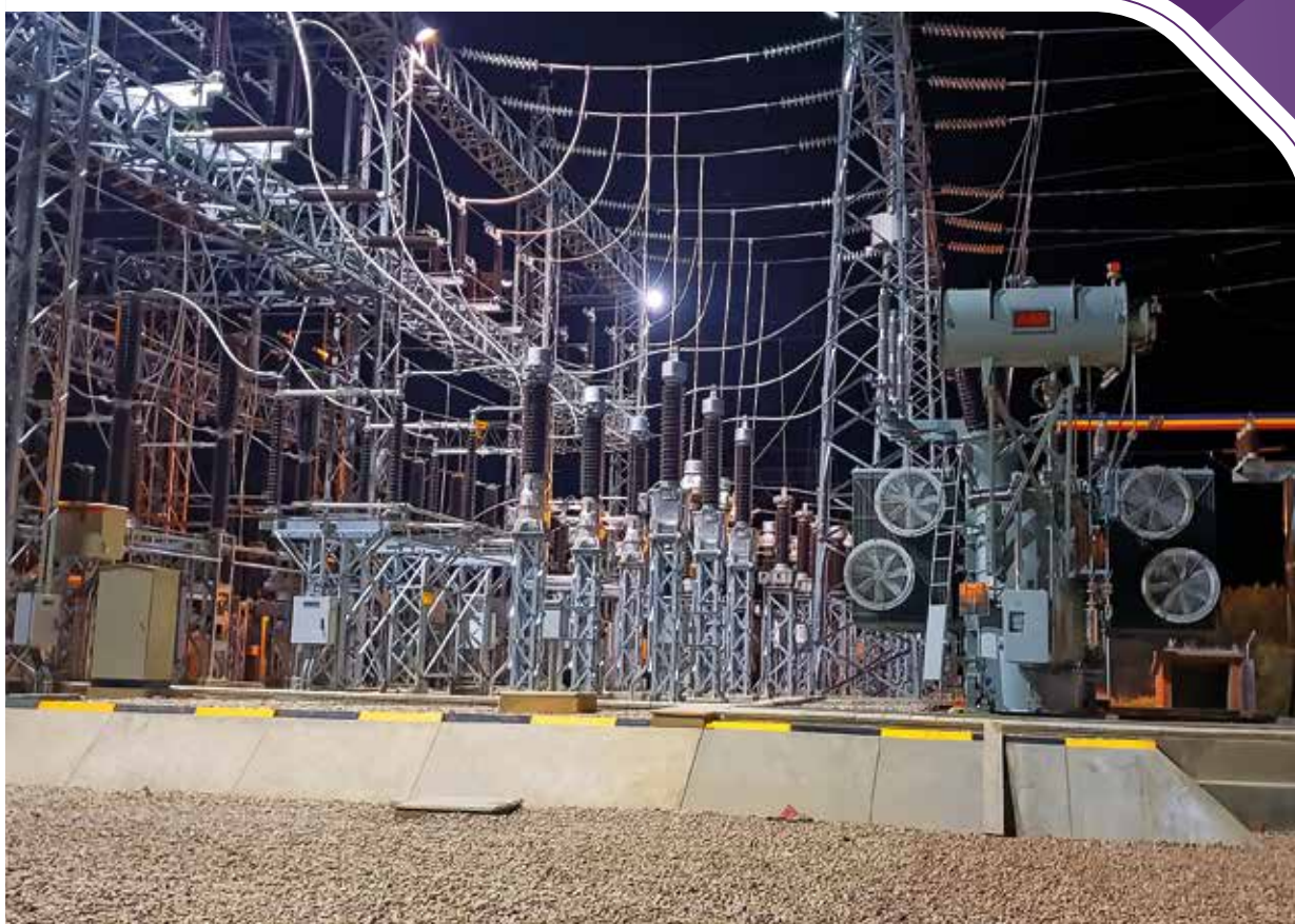
Transformador de Potencia 50 MVA (T13) en Subestación Sucre - CESSA
