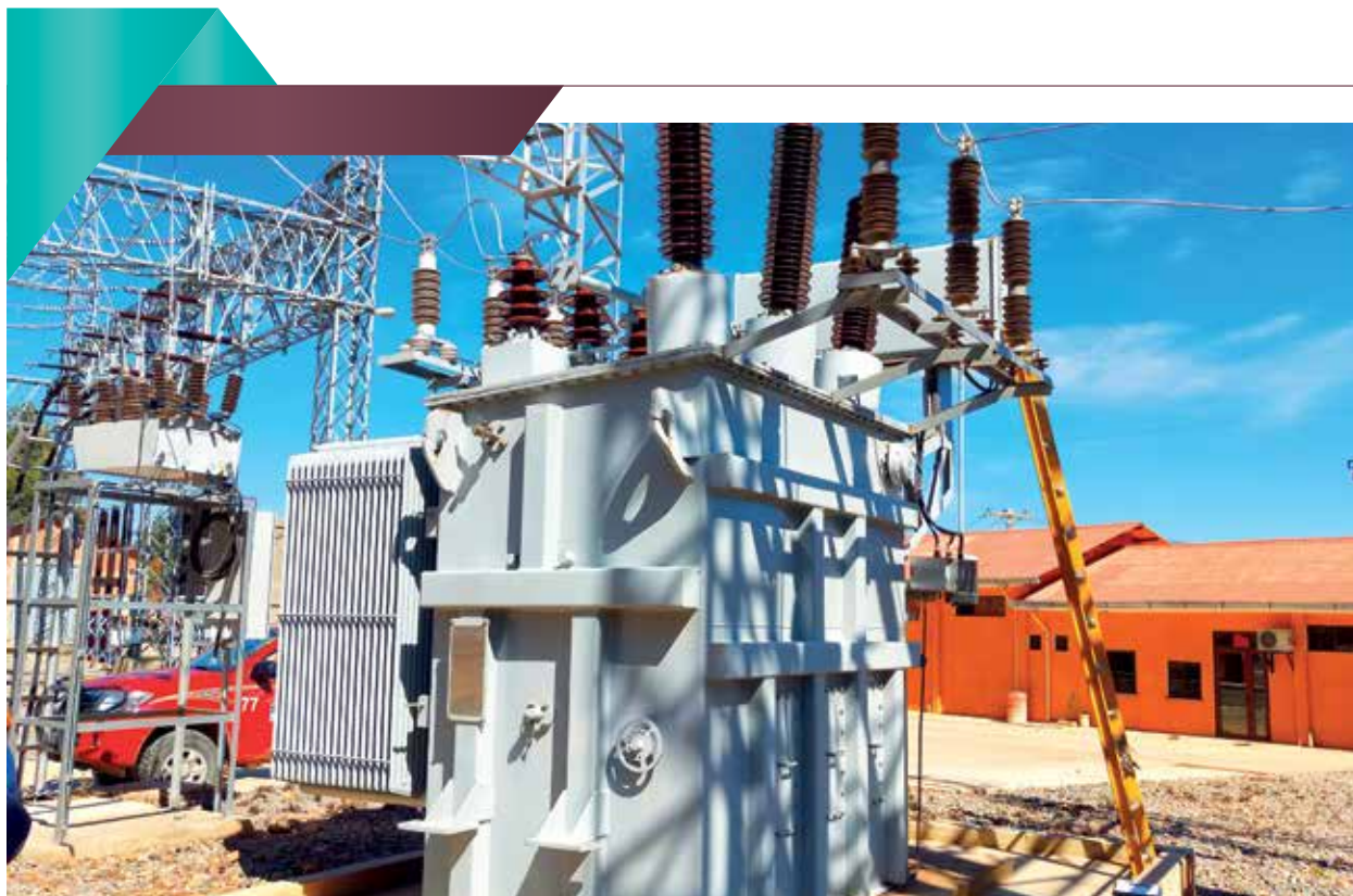
Transformador de 3 MVA en Subestación Velarde II - SEPSA
