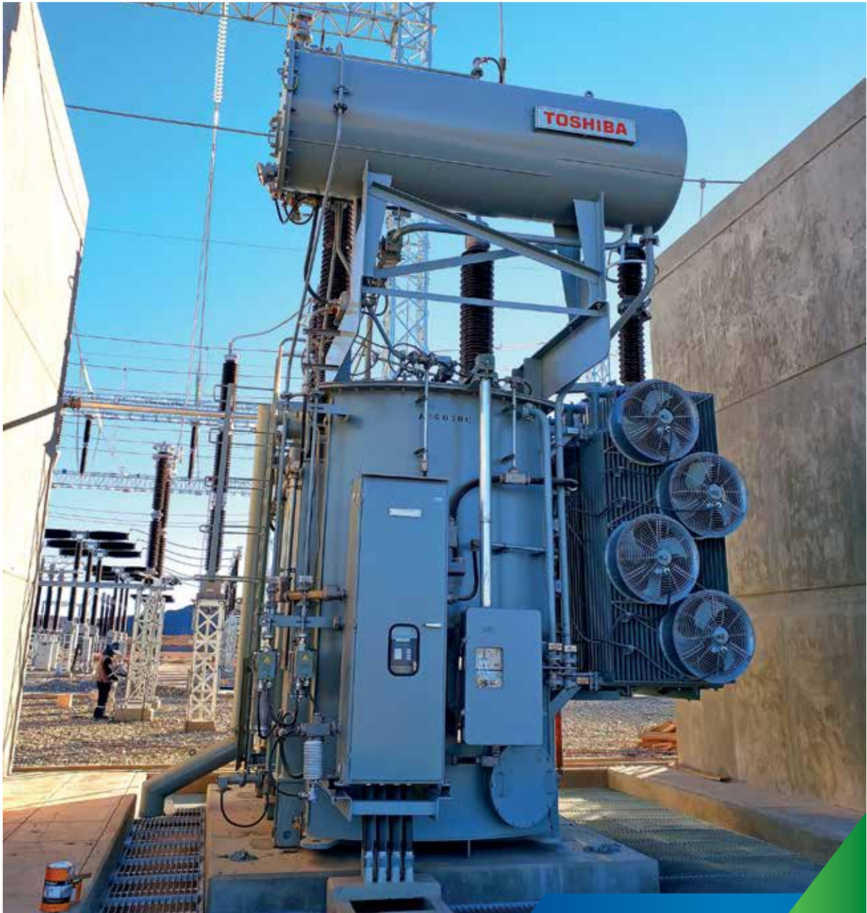
Banco de Autotransformadores Subestación Lito - Anillo Energético del Sur - ENDE TRANSMISIÓN
