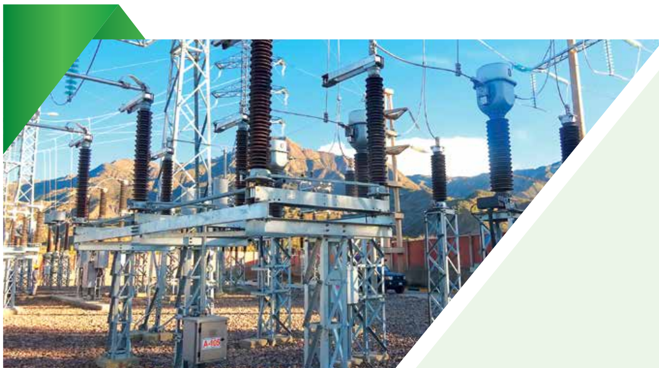
Bahía 115 kV en subestación Irpa Irpa - COBOCE
