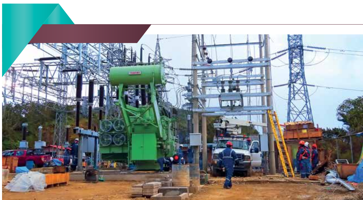
Subestación Chuspipata, Transformador de Potencia - DELAPAZ
