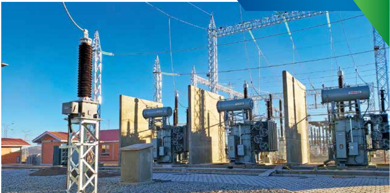
Banco de Autotransformadores Subestación Litio - Anillo Energético del Sur - ENDE TRANSMISIÓN
