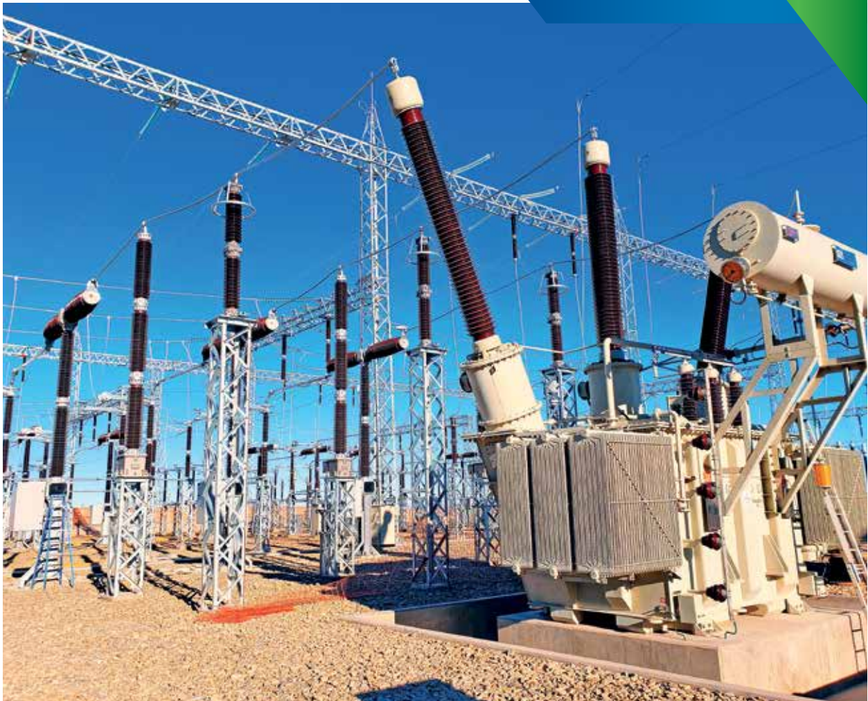
Banco de Autotransformadores Subestación Lito - Anillo Energético del Sur - ENDE TRANSMISIÓN
