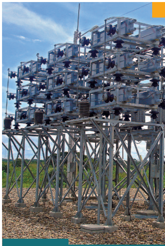
Banco de Capacitores Subestación Trinidad
