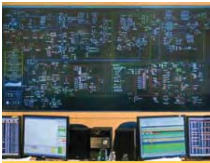
Diagrama del SIN, MIMICO, Sala de Control del CDC
