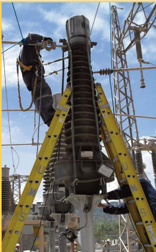
Cambio CT - Subestación Coboce Cemento.
