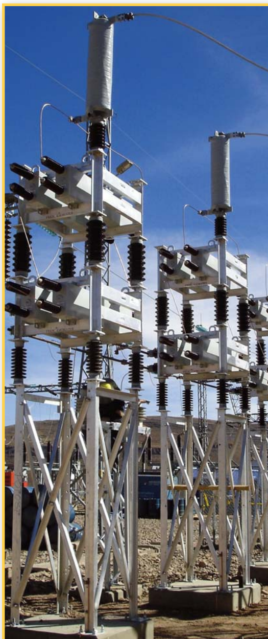
Banco de Capacitores - Subestación Atocha.
